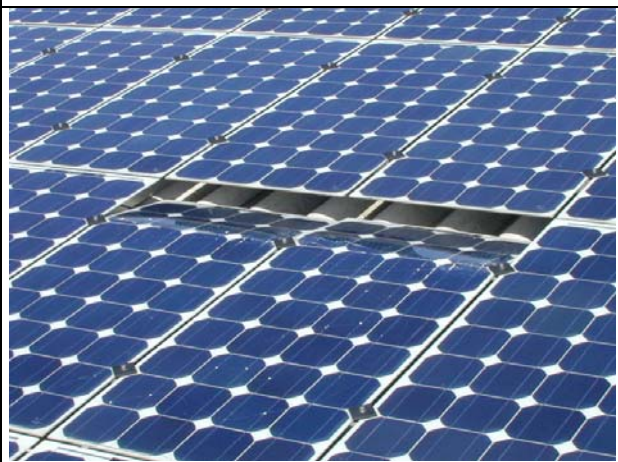
Schäden wegen Montagefehlern
